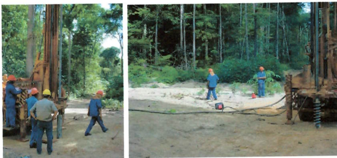
Figura 24 – Execução de furos de sondagem.
