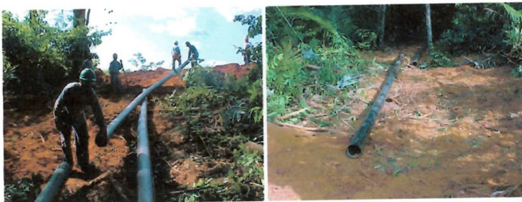
Figura 22 – Lançamento de tubulação para drenagem dos platôs.
