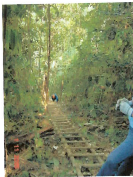
Figura 16 – Construção da escada de acesso. Fonte: Relatório de investigação de acidente da Mavefer Engenharia, 2005.
